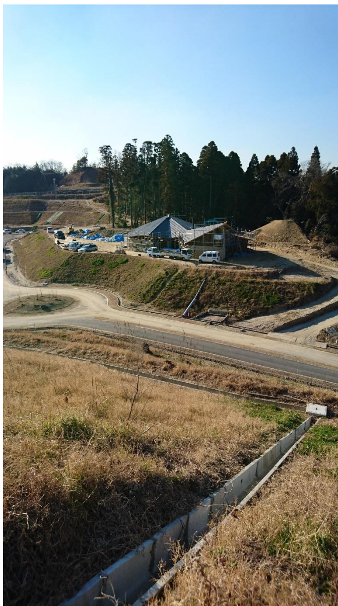
二期工事中の土太郎村。
