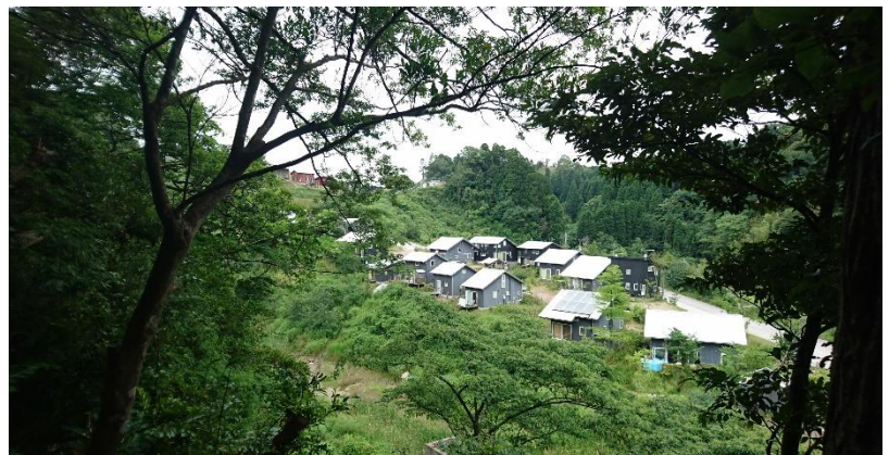
ゴルフ場1番ホールから見た1期工事の「小さな集落」
